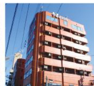
TSビル I・II 平成8年4月竣工 名古屋市中川区八田町107-1
